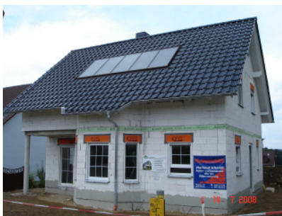
Bauvorhaben in Brand-Erbisdorf
