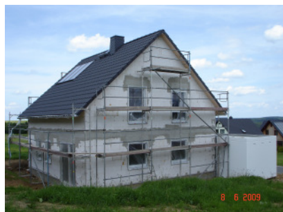
Bauvorhaben in Berthelsdorf
