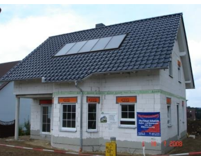
Bauvorhaben in Brand-Erbisdorf
